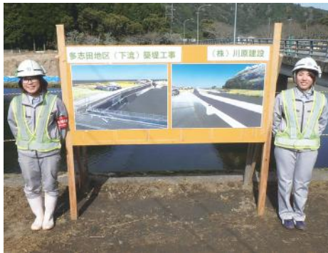
工事現場の案内板にもCIMモデルが大活躍
