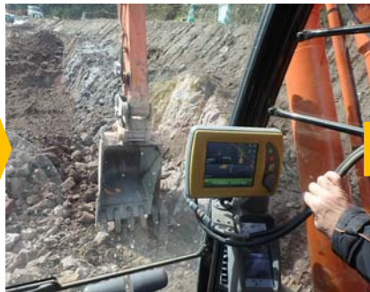
ICT建設機械による施工
