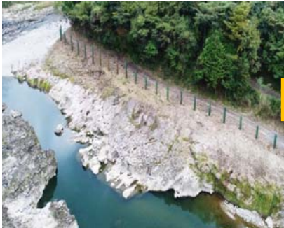
レーザースキャナーによる起工測量
