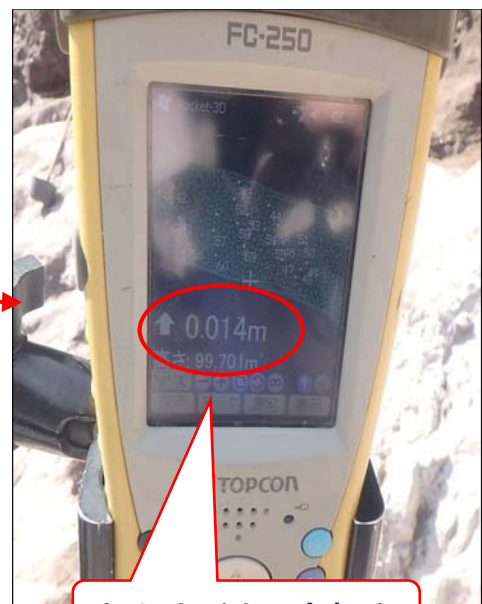
掘削高が表示される
